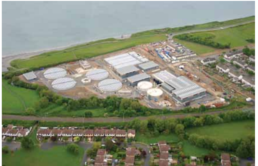
186,000 PE Shanganagh WWTW Dublin, Ireland
